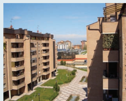
Esempio di corretto insediamento urbano (Edifici in via Marco Polo, Bologna).
